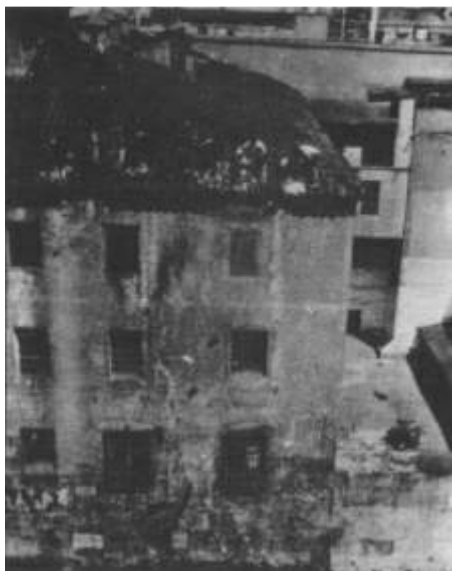
Destrucción de la cárcel de mujeres de Barcelona por militantes del sindicato de construcción de CNT, en 1936.
